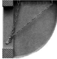
Gitterrostarretierung Befestigung im Mauerwerk beim Kunststofflichtschacht
